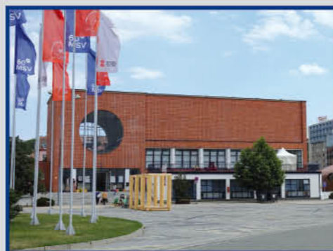
Brněnské výstaviště - Pavilon Morava
